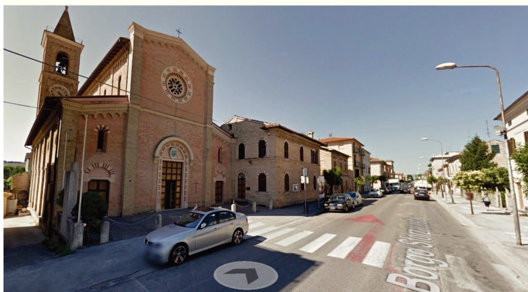
Antenna su campanile chiesa S. Giuseppe
