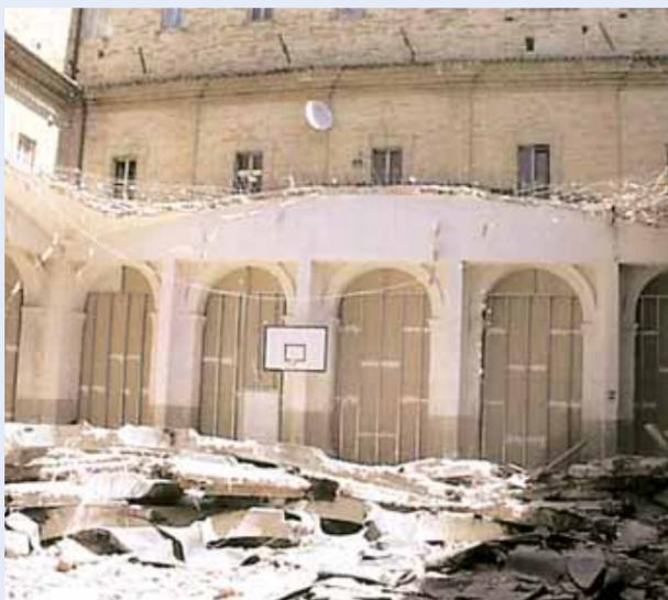
cupola di cemento armato sopra la palestra che verrà ricostruita con una struttura portante in acciaio e vetro.
